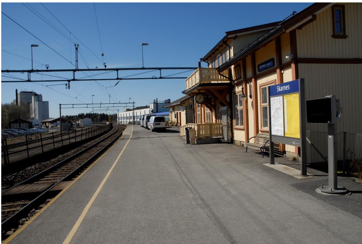
Figur 14 Billede af stationsanlægget i Skarnes. Foto Jernbaneverket.
