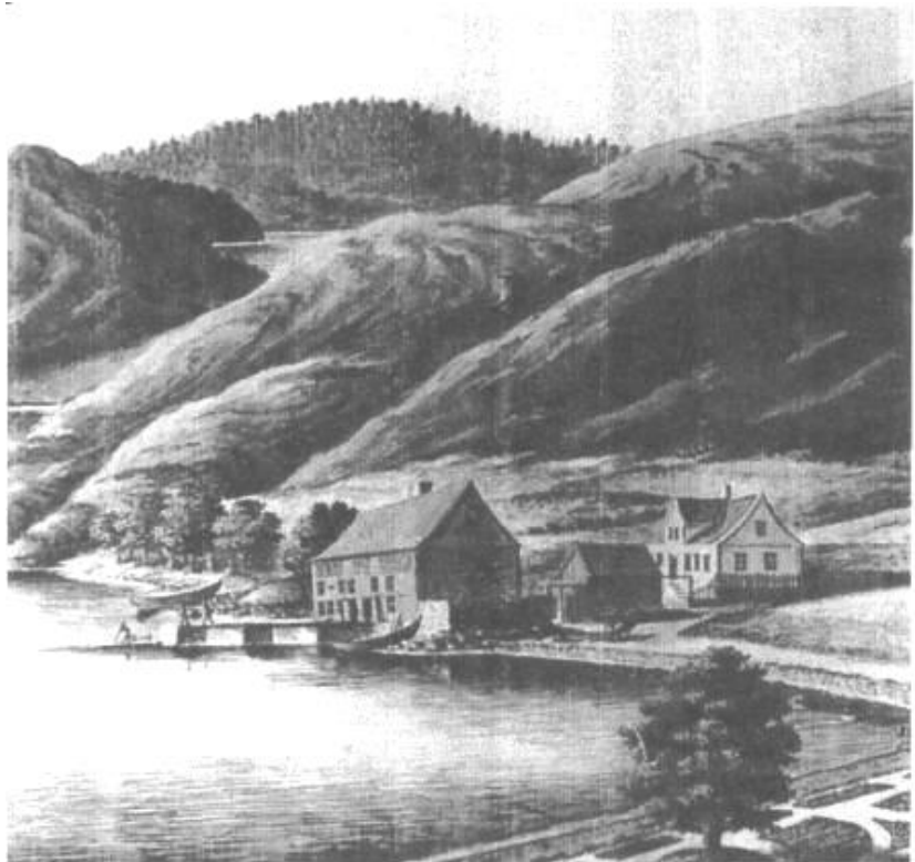
Garveriet som sto ferdig i 181
